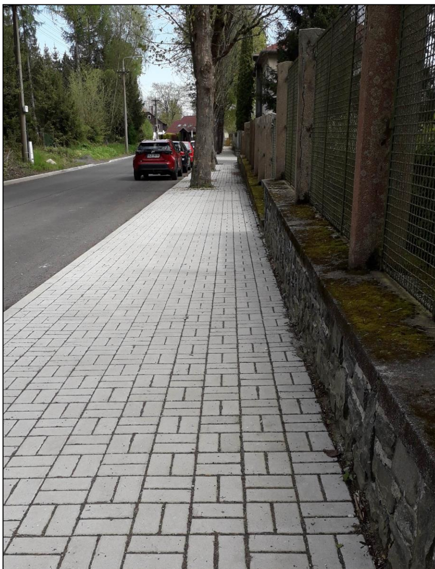
Nová chodník u nemocnice – ul. Karlova
