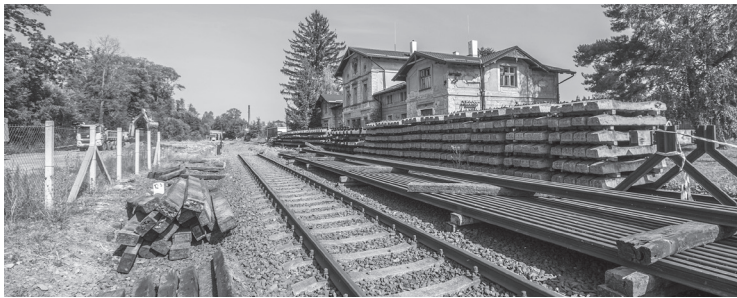
Rekonstrukce trati stále přes 70 milionů; foto Tomáš Secký
