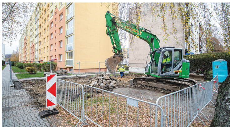
V lokalitě Pražská začala instalace polopodzemních kontejnerů; foto Tomáš Secký
